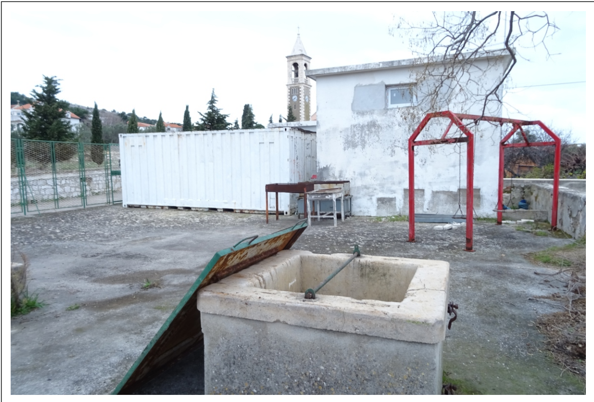
Fotografija 16. Kontejner i vatrogasna kuća sa zapadne strane gusterne
