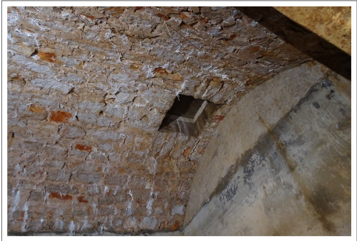
Fotografija 5. Nekadašnji otvor na stropu prostorije 3 zatvoren betonskom pločom
