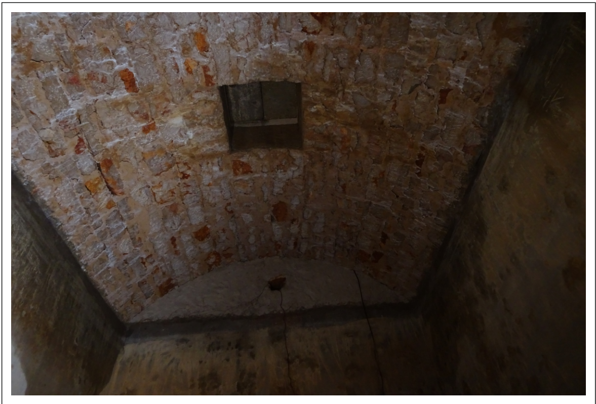
Fotografija 9. Kameni lučni svod u prostoriji 5 i zatvoreni otvor u stropu
